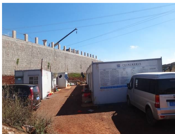
2#施工生产生活区现状（2017.3）
