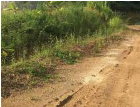
厂内道路土质排水沟
