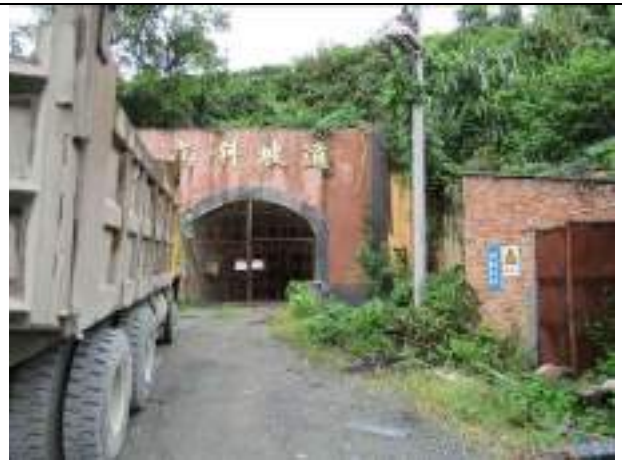
工业场地绿化（南部斜坡道）
