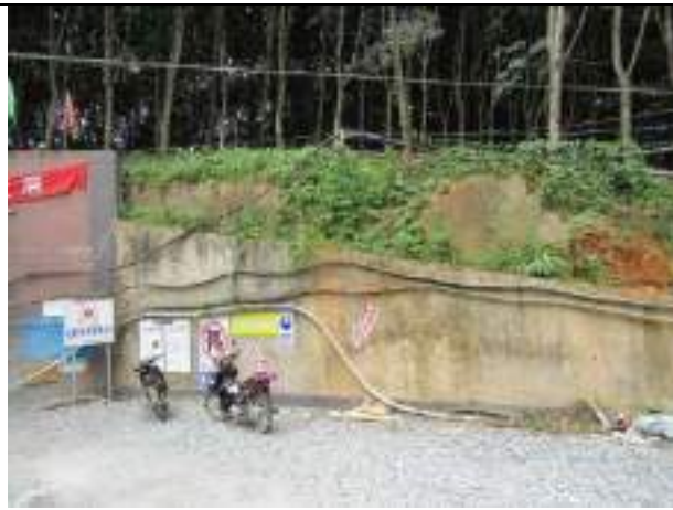
工业场地绿化（北部斜坡道）
