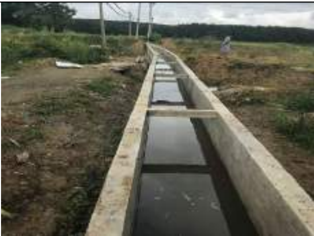
废石场区钢筋砼水沟改道
