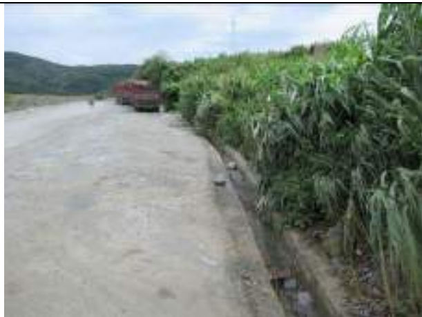
厂内道路浆砌石排水沟
