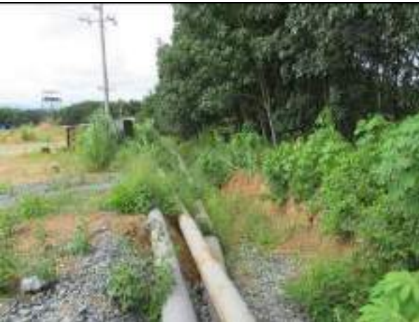
废石场区土质截洪沟
