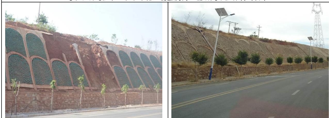
原设计拱形框格梁植生袋护坡区域边坡不稳定，发生垮塌，后变更为拱形框格梁浆砌石工程护坡，现能保障主体工程边坡稳定同时起到水土保持的作用
