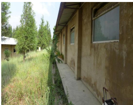
绿化及砖砌排水沟
