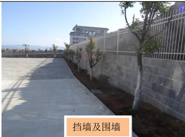
附属设施中管线工程均埋于地下，地表进行硬化处理无水土流失，挡墙及围墙已建设完成，现场无明显水土流失。
