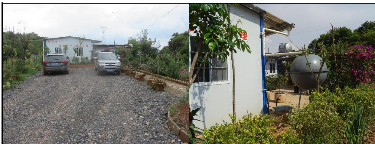
办公生活区现状 2019.10.20
