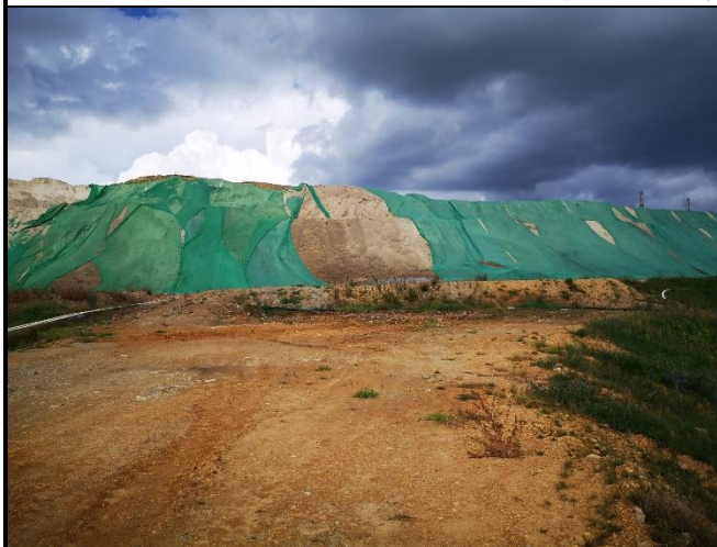
磷石膏堆场无纺布覆盖
