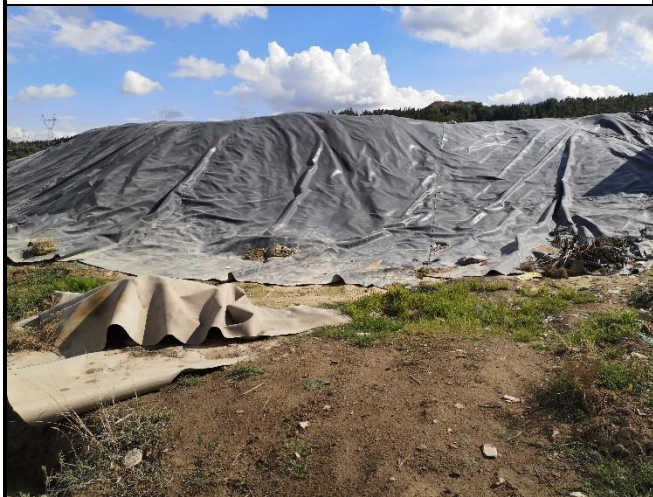
1#原料堆场土工布覆盖
