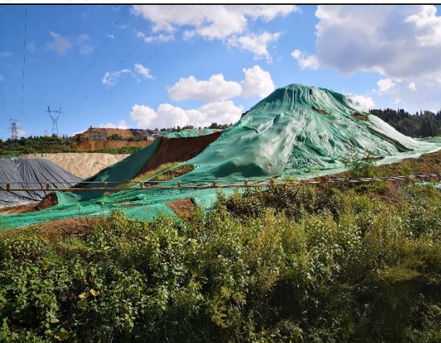
1#原料堆场无纺布覆盖
