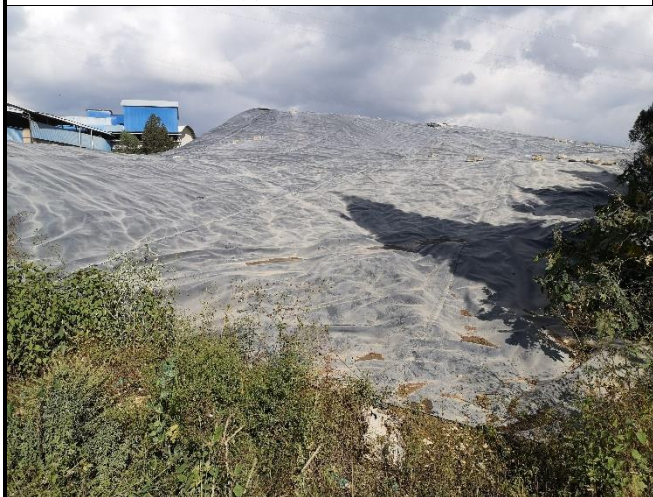
3#原料堆场土工布覆盖
