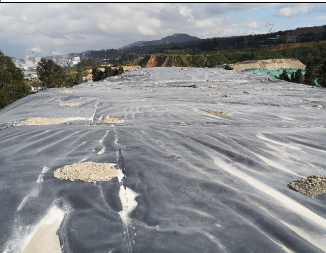
2#原料堆场土工布覆盖
