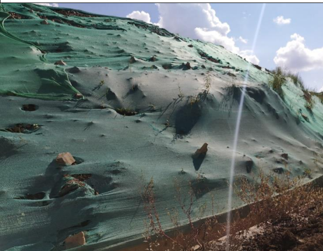
4#原料堆场无纺布覆盖
