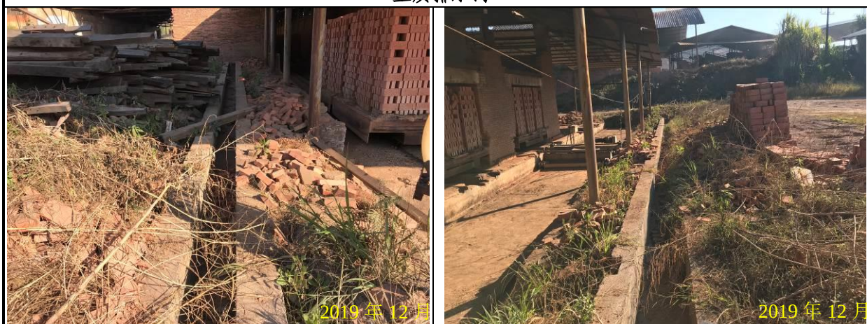
生产区砖砌排水沟
