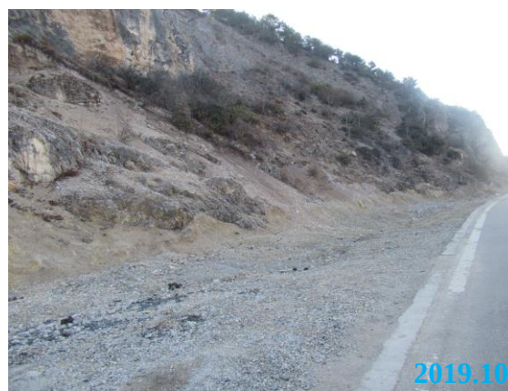
2#新增落水洞清淤完成现状
