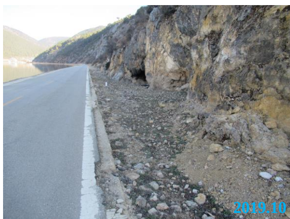
1#新增落水洞清淤完成现状
