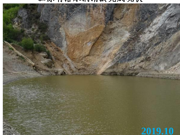
8#原有落水洞清淤完成现状
