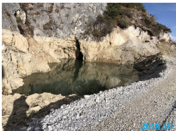
3#原有落水洞清淤完成现状
