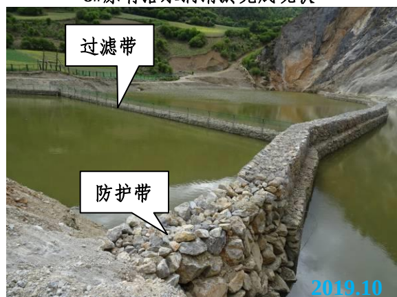
格宾石笼过滤带、防护带（7、8#落水洞洞前）
