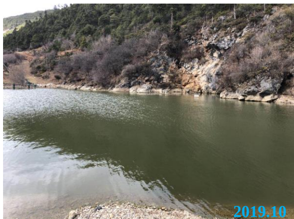
1#原有落水洞清淤完成现状
