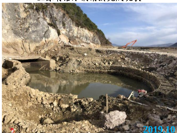
5#原有落水洞清淤完成现状
