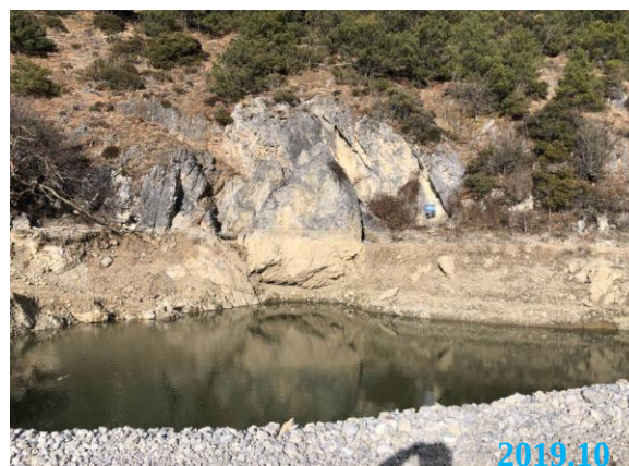
4#原有落水洞清淤完成现状
