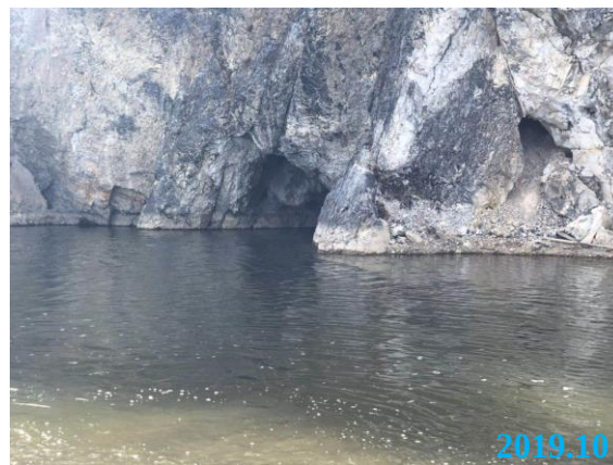
2#原有落水洞清淤完成现状
