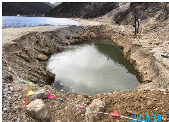
2#新增落水洞清淤完成现状
