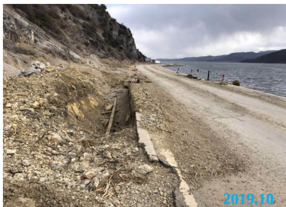
1#新增落水洞清淤完成现状
