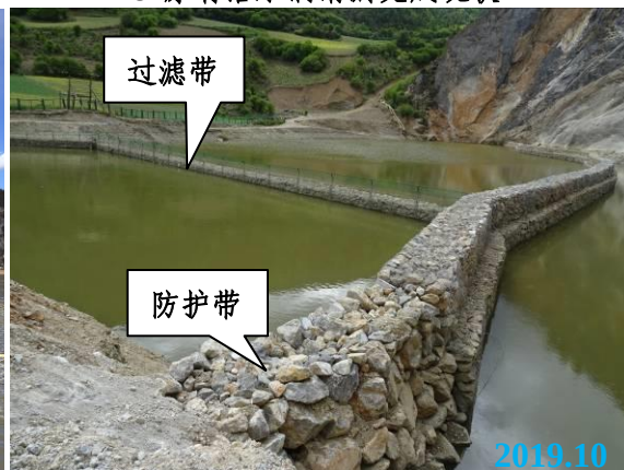
格宾石笼过滤带、防护带 (7、8#原有落水洞洞前)
