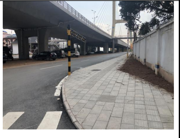
勐罕岸引桥配套人行天桥（2020.1）
