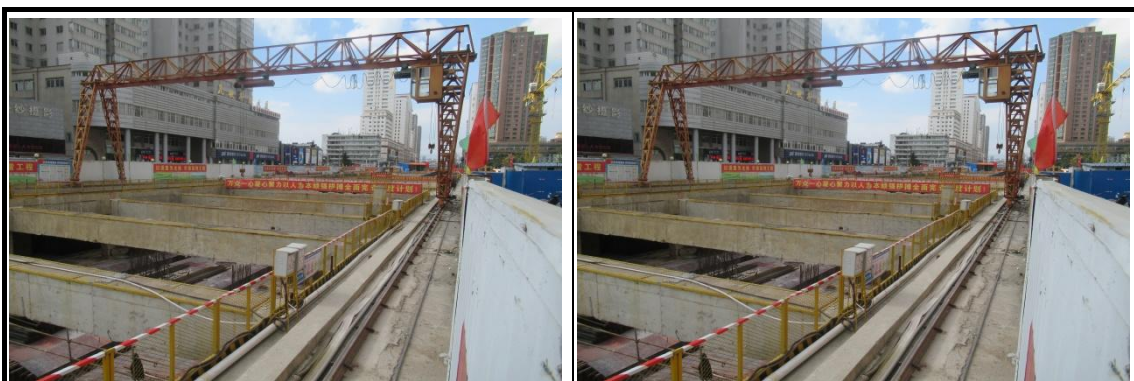
二期地下车站区（2016 年 12 月）
