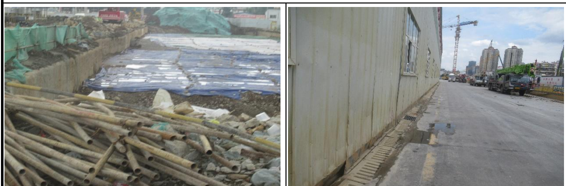
二期地下车站区（2019 年 12 月）
