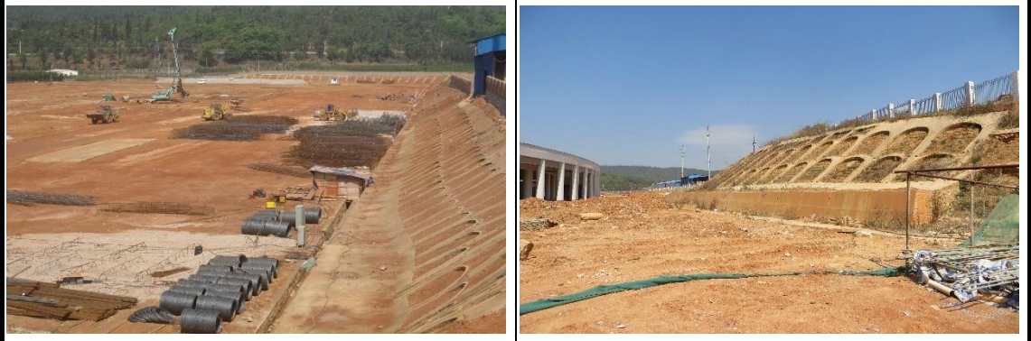
大板桥车辆段区网格植草护坡（骨架）
