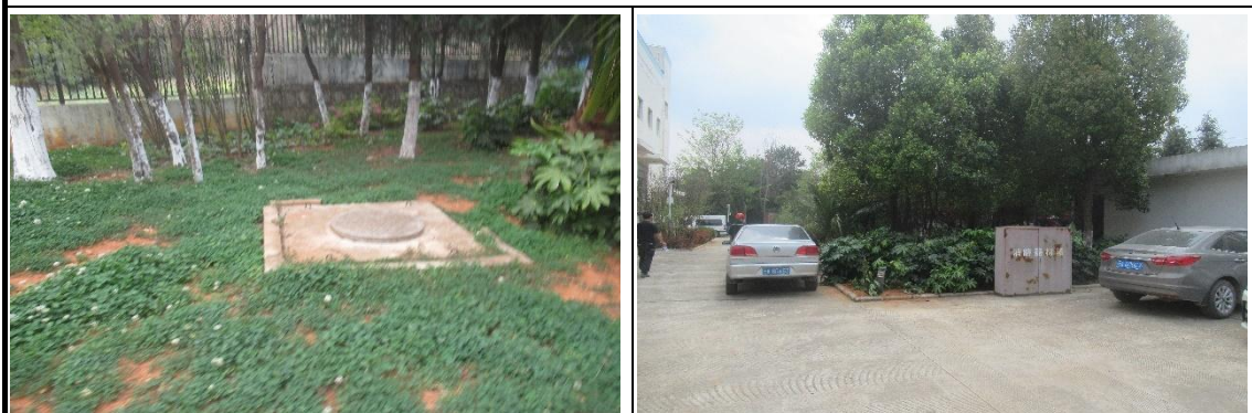
大板桥主变电所区绿化
