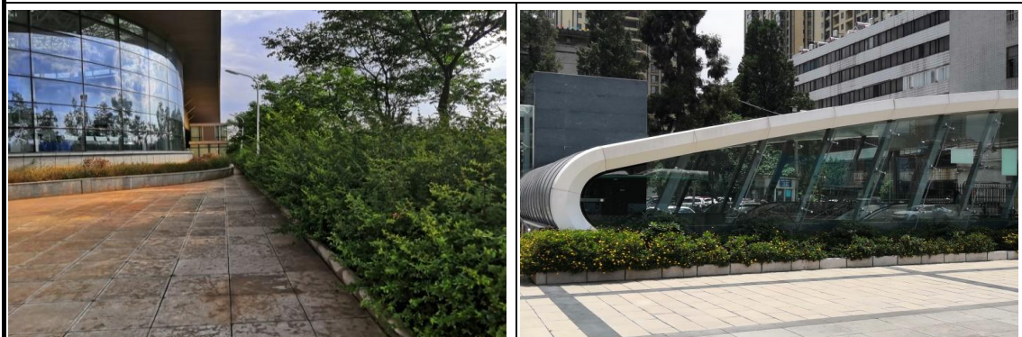
二期地下车站区（2020 年 5 月）
