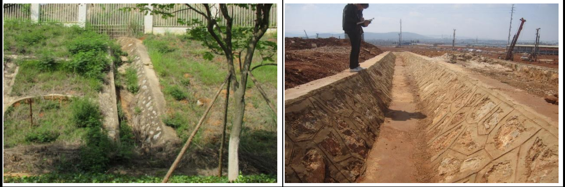
大板桥车辆段浆砌石截洪沟
