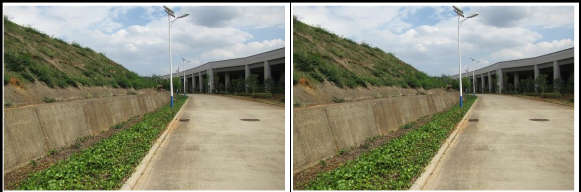
大板桥车辆段区混凝土挡墙
