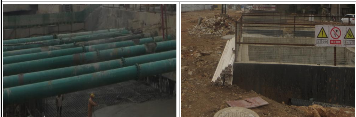
二期地下车站区（2018 年 12 月）
