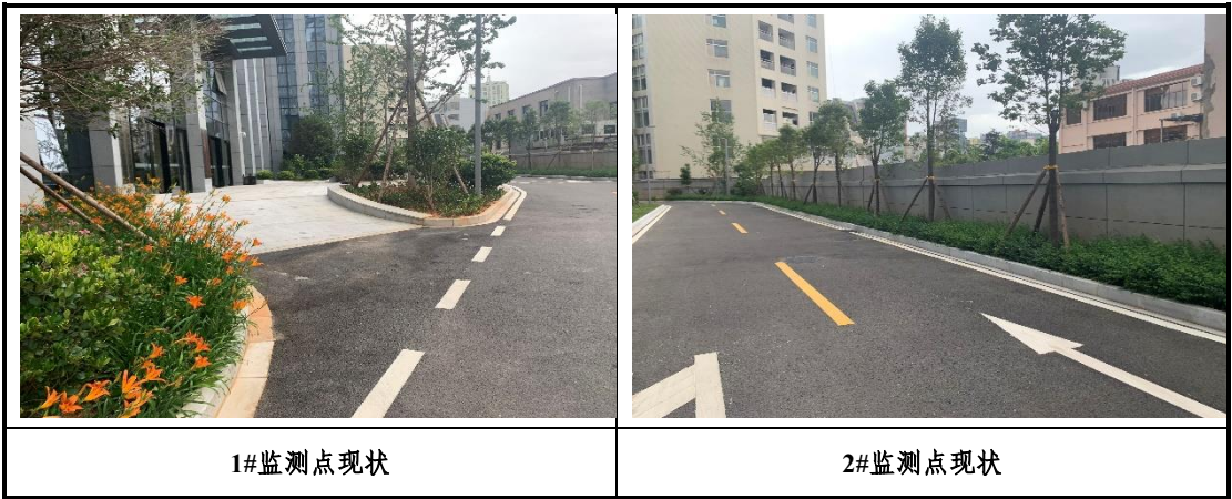
图 1-1 工程部分水土保持监测点现场照片
