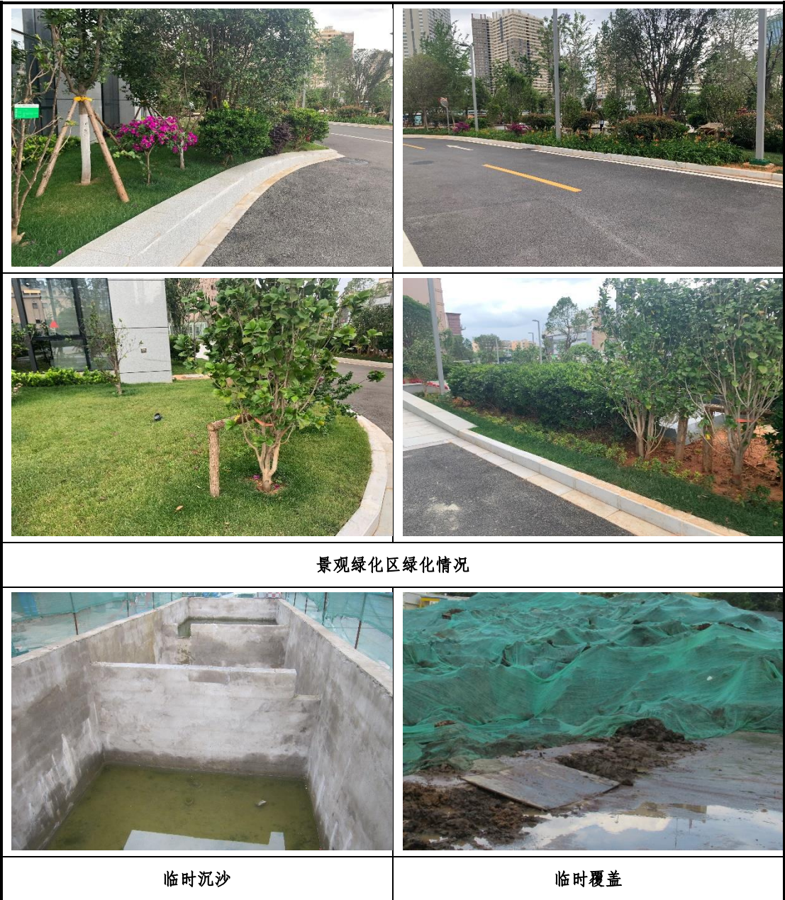
图 4-1 工程已部分实施的水土保持措施现状
