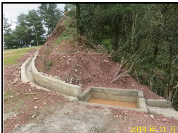
风机机组区沉沙池
