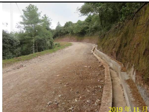
场内道路区排水沟（浆砌石+C20 砼浇筑）
