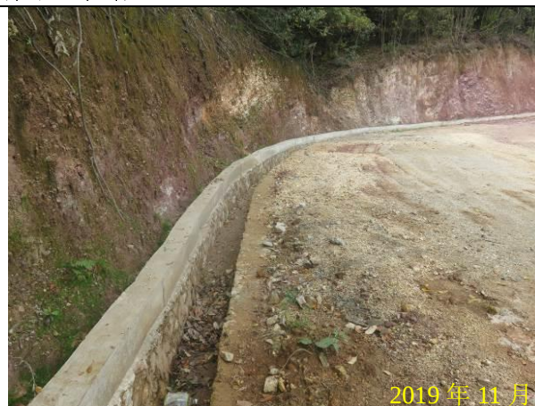
场内道路区排水沟（浆砌石+C20 砼浇筑）
