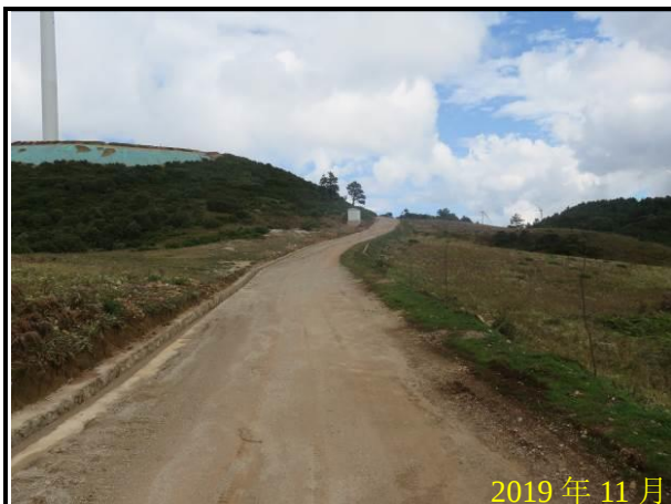
场内道路区排水沟（浆砌石+C20 砼浇筑）
