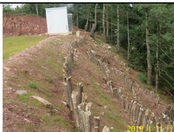
风机机组区松木桩
