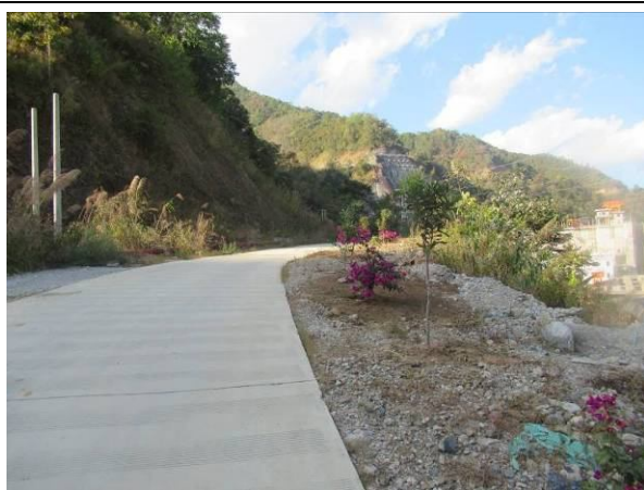
道路工程区现状（2019.12）
