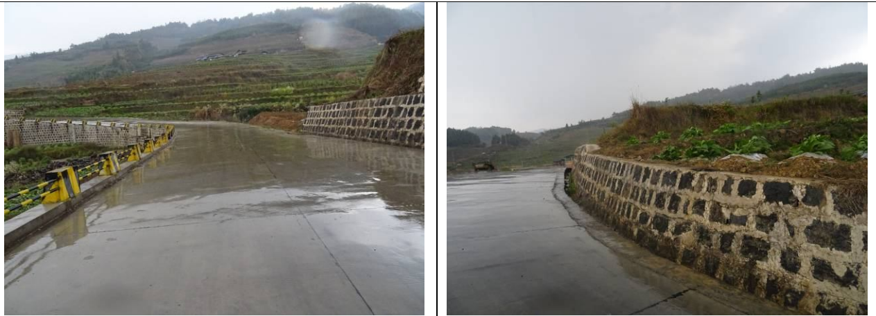
专项设施复建区现状（2019.9）
