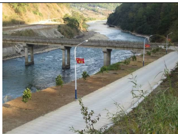
道路工程区现状（2019.12）
