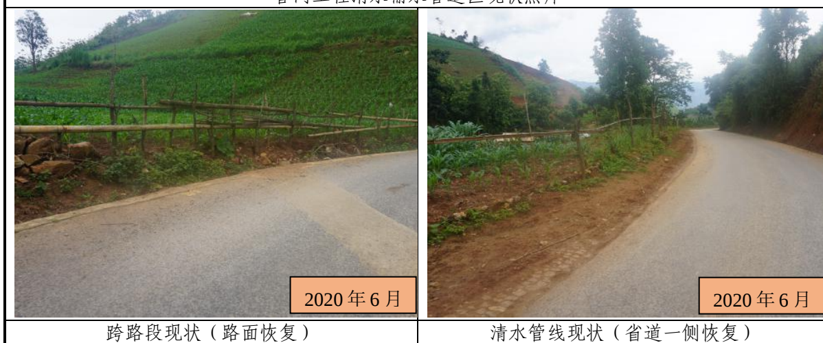
管网工程清水输水管道区现状照片
