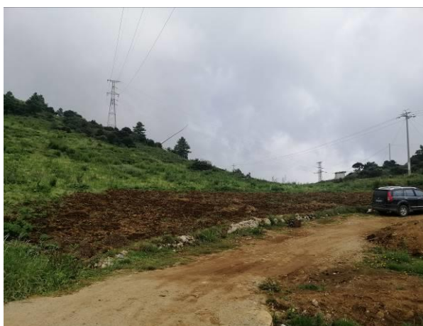
图 1-15 施工生活区已拆除并复耕区域
