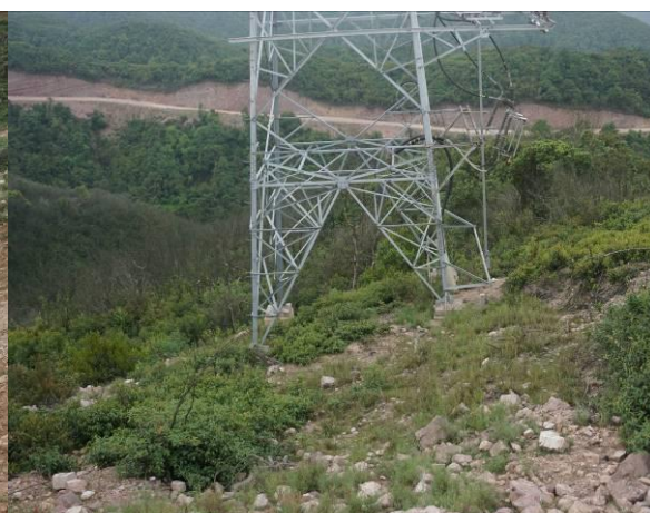
图 1-6 集电线路区塔基
