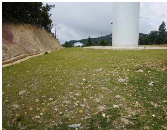
图 1-2 风机安装平台
