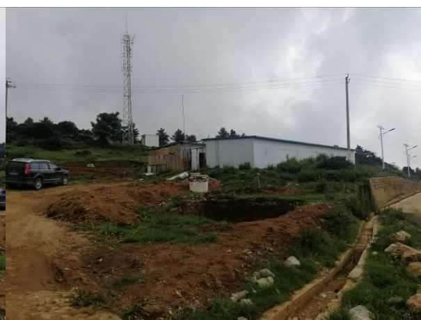
图 1-16 施工生活区暂未拆除区域
