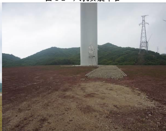
图 1-4 风机安装平台
