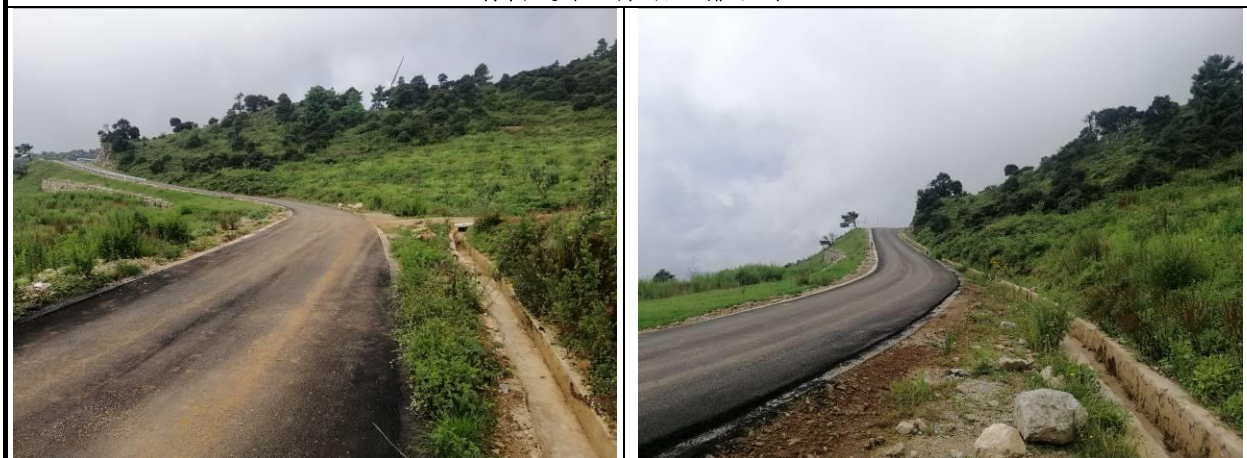
场内道路区 C20 砼排水沟
