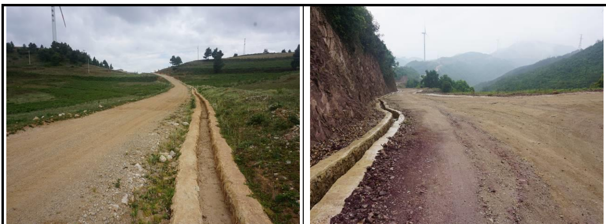
场内道路区浆砌石排水沟
