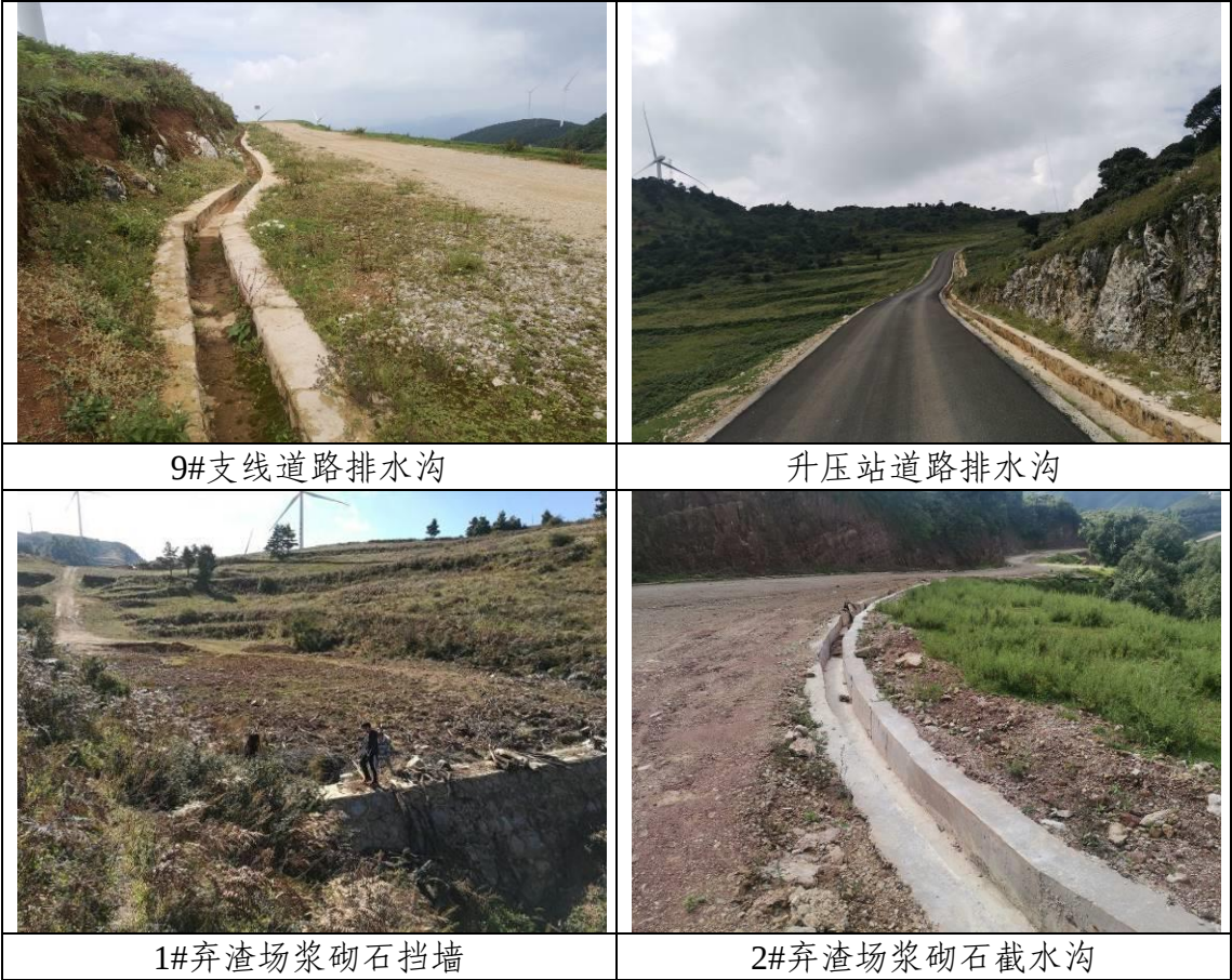
图 4-1 工程措施实施情况图
