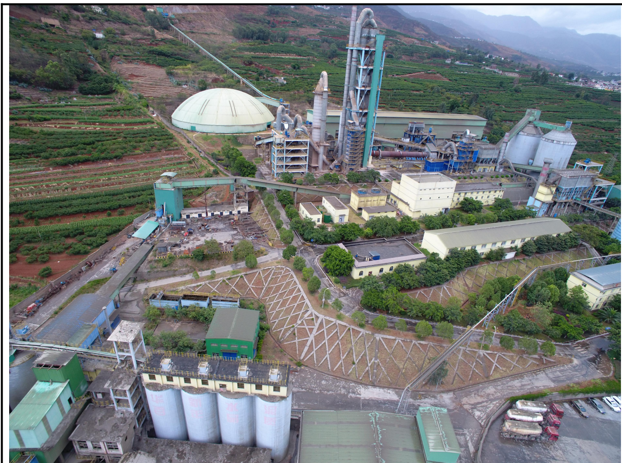
项目区整体现状（2021.6）
