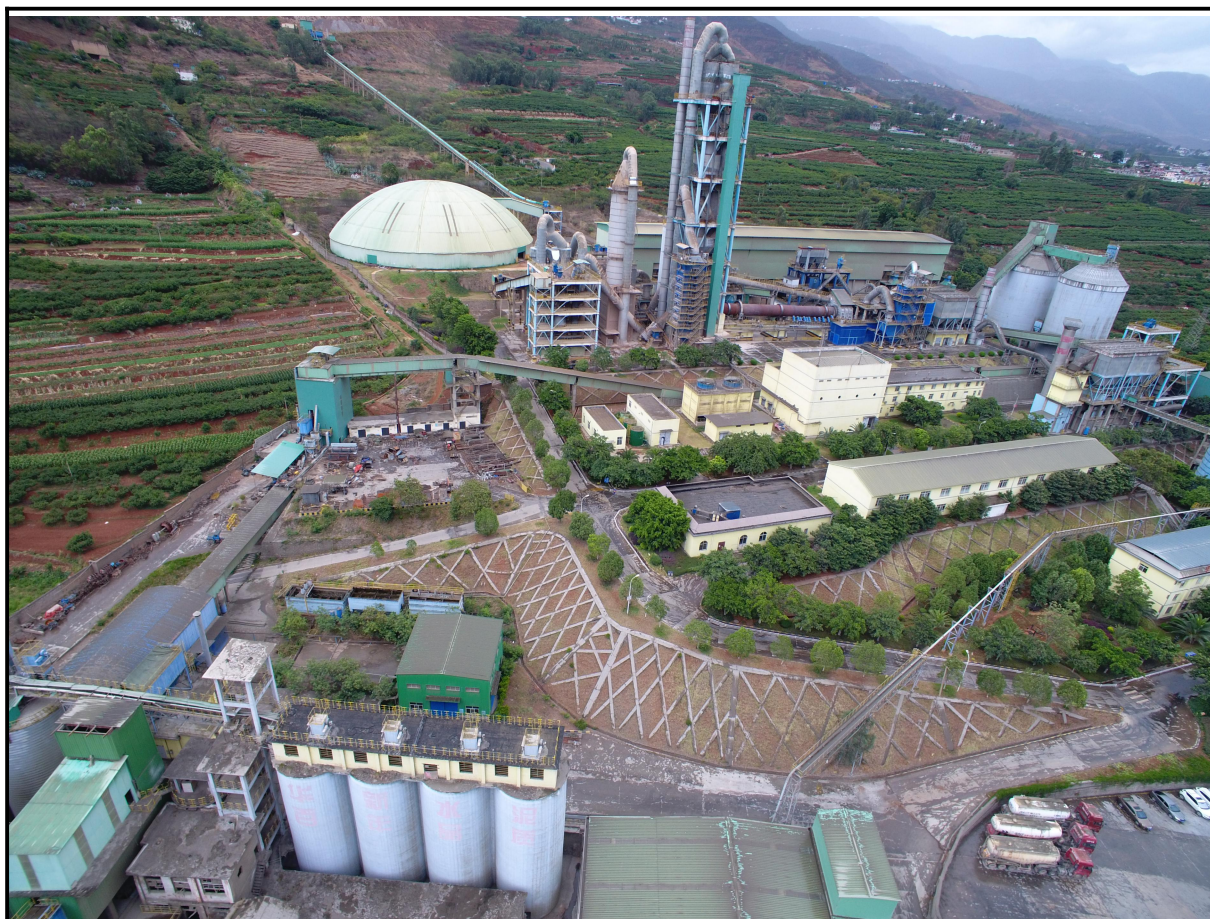
项目区现状（总体）
