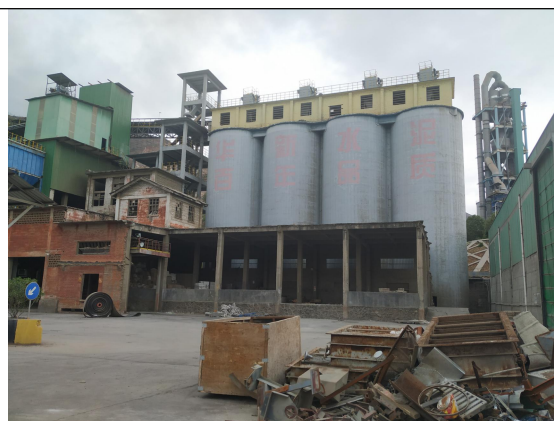
项目区保留建筑
