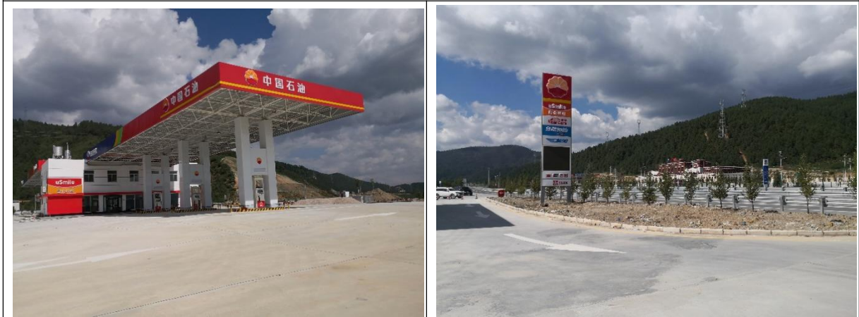
站房、罩棚、加油区建设现状
