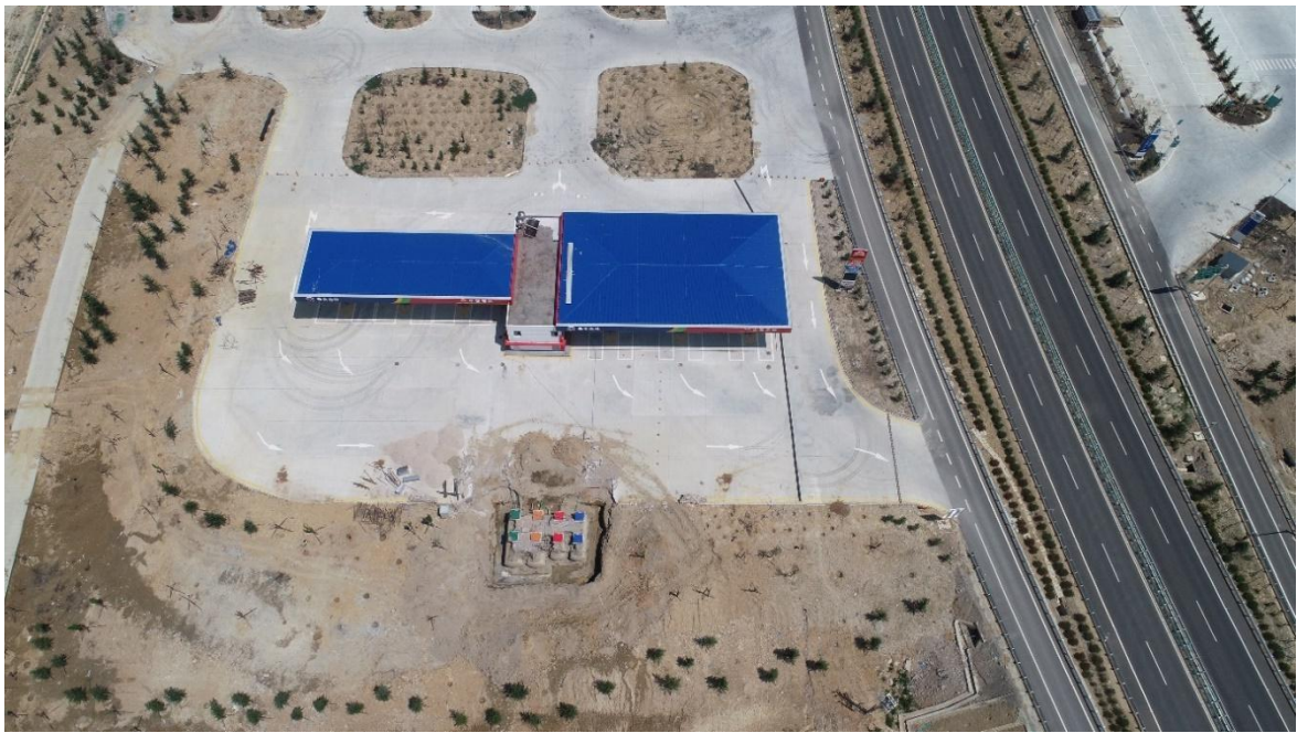
项目区水流现状（为建构筑物、硬化覆盖，绿化区正在施工，植被覆盖度较低）
