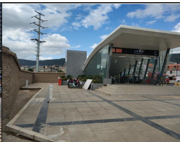
车站区-大河坝站（2021.12）
