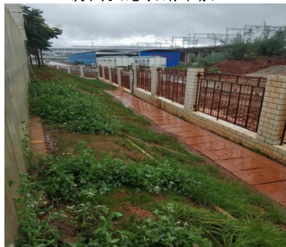
盖板排水沟（白龙潭停车场）
