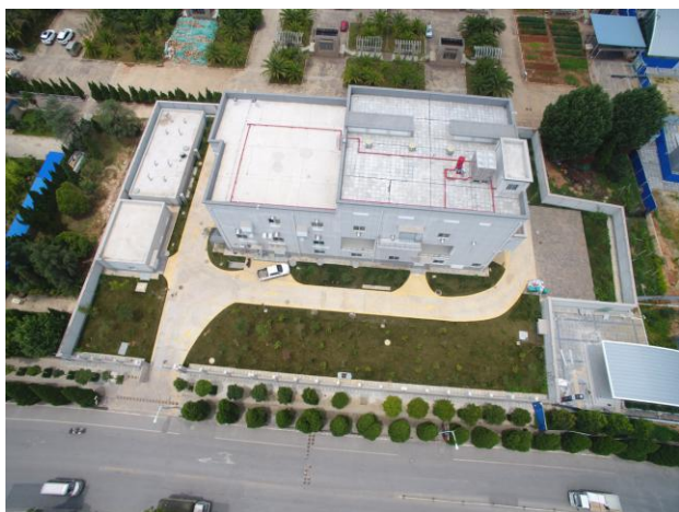
主变电所场地绿化
