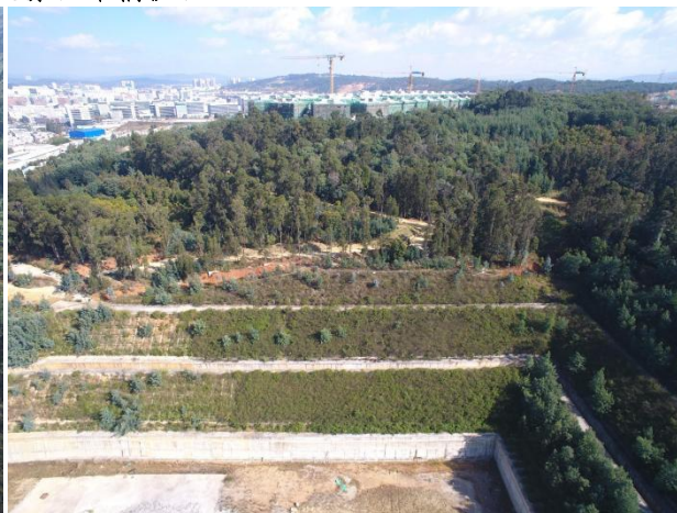
混凝土排水沟（跑马山停车场）
