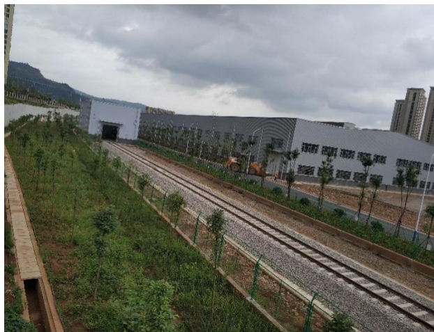
盖板排水沟（大漾田车辆段）
