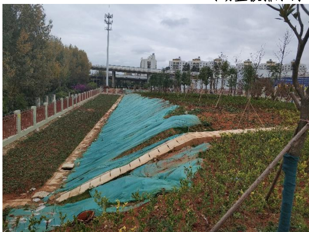
混凝土盖板排水沟（跑马山停车场）
