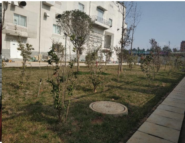
砖砌排水沟（主变电所）
