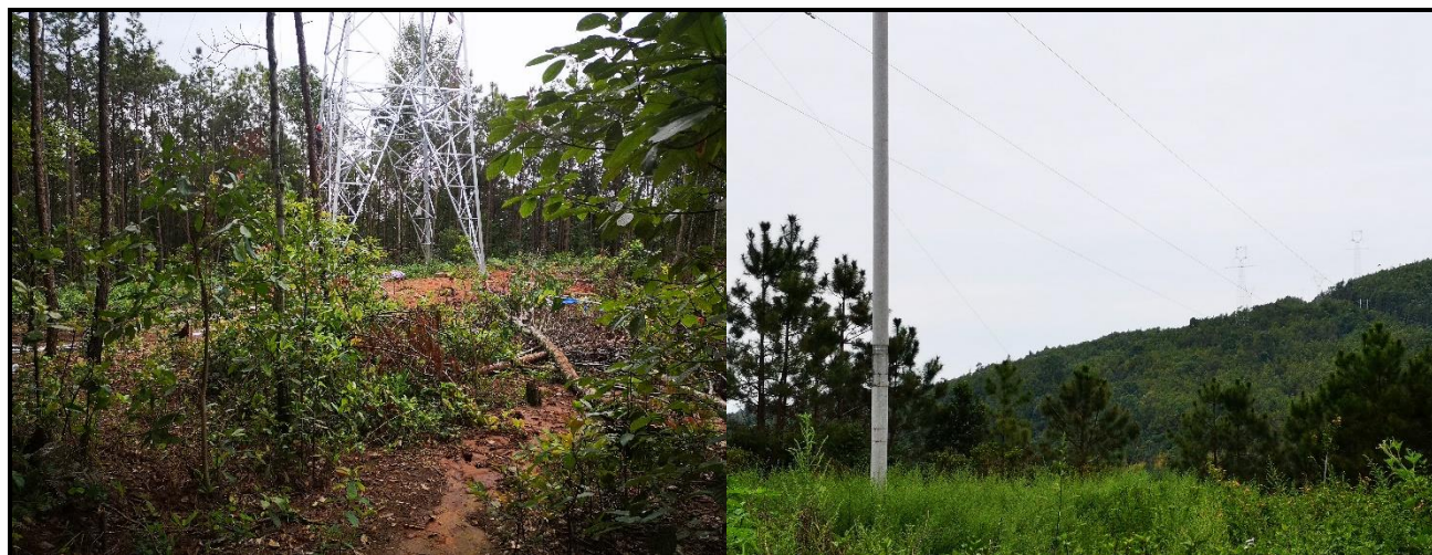
施工场地区现状 2020 年 12 月
